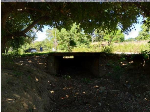
FOTO 05: Alguns dos sistemas de drenagem existente nota-se a necessidade de limpeza, desobstrução de galerias, sarjetas e outros ao longo do município, a solução ideal é a criação de roteiro e cronograma de execução de limpeza de sistema de drenagem tais como galerias, sarjetas e outros.
